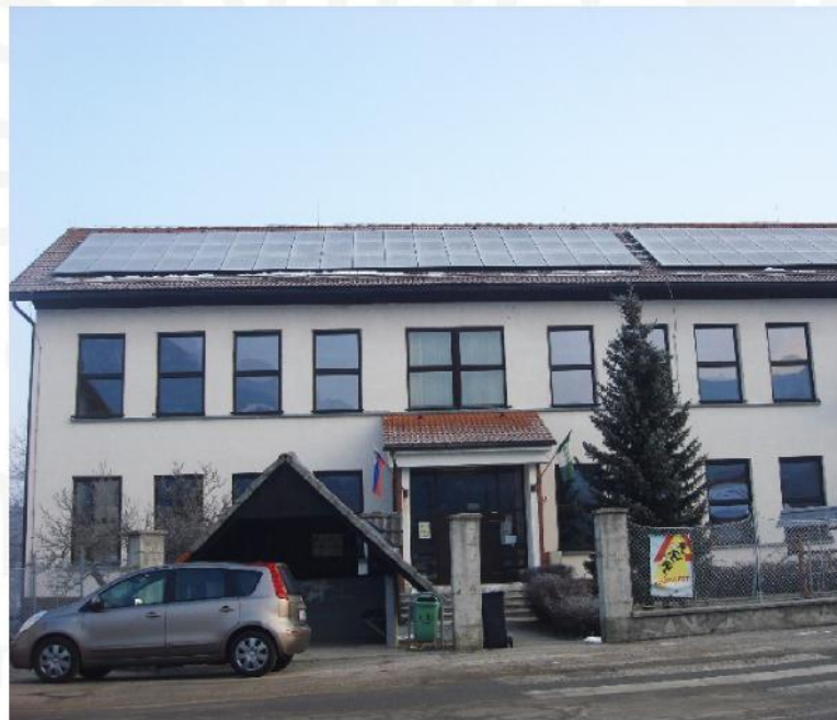
Solarni sustav na školskoj zgradi
